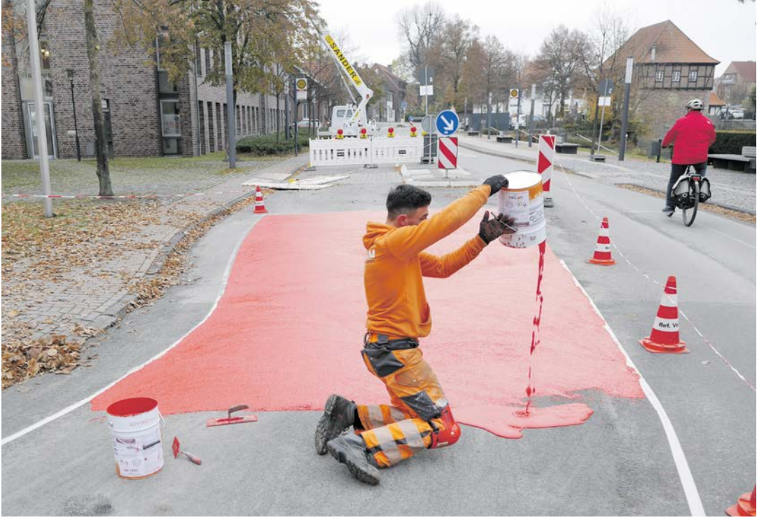
Der aktuelle Bauabschnitt auf der Stadtfeldstraße hat auch eine Ausweitung der bereits vorhandenen Fahrradstraße als Ergebnis. Foto: Stadt Lüdinghausen
