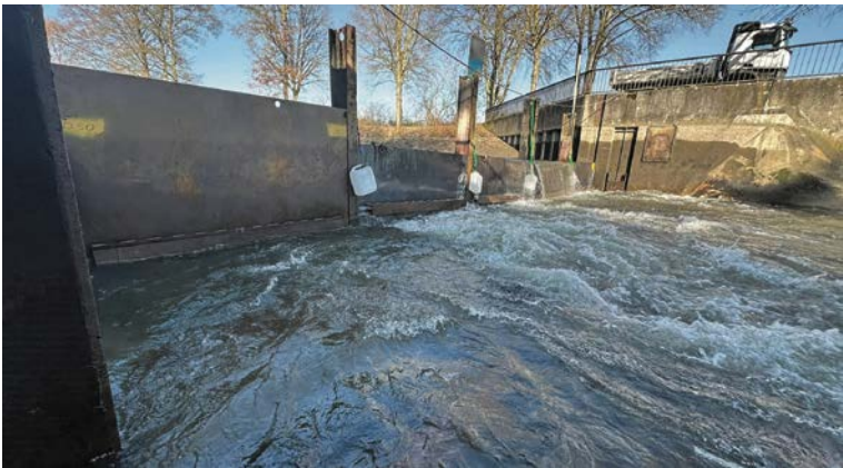
Die Grüne Schleuse ist wieder instandgesetzt. Foto: Stadt Lüdinghausen
