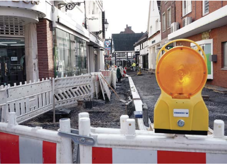
Die Bauarbeiten auf der Kleinen Münsterstraße schreiten voran. Der Abschluss aller Arbeiten ist für den Frühsommer geplant. Foto: Stadt Lüdinghausen
