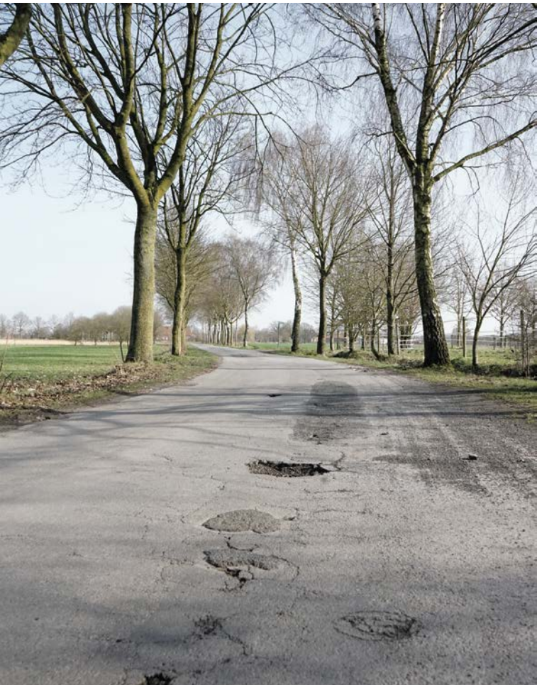
Die Westruper Straße wird saniert. Foto: Stadt Lüdinghausen
