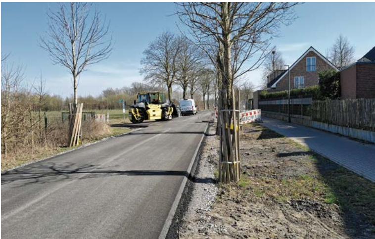
Die Arbeiten an der Stadtfeldstraße gehen weiter zügig voran. Die ersten Bauabschnitte werden in diesen Tagen freigegeben. Foto: Stadt Lüdinghausen
