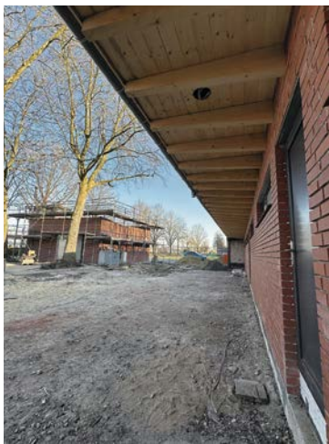
Rohbau- und Zimmerarbeiten sowie Dachdecker- und Innenausbauarbeiten zu den Umkleidekabinen am Stadion sind abgeschlossen.
