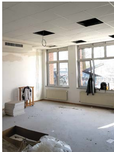
Altbestand eines Klassenraumes an der Ludgerischule.
