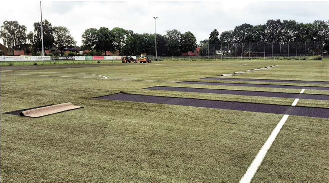
Der Kunstrasenplatz am Westfalenring wird derzeit saniert.
