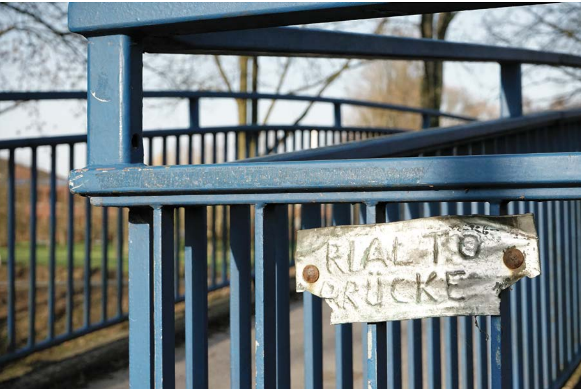
Nach vielen Jahren der Diskussion eröffnet sich die Möglichkeit, für die Rialtobrücke eine tragfähige Lösung zu finden. Grund dafür ist die Zusage für Fördermittel aus dem Nahmobilitätsprogramm von Bund und Land. Foto: Stadt Lüdinghausen
