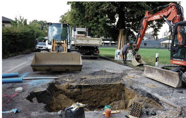
Wenn die erforderlichen Kanalbauarbeiten abgeschlossen sind, steht der Endausbau der Baugebiete an. Foto: Stadt Lüdinghausen
