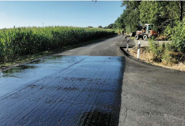
Die Westruper Straße ist für den Verkehr wieder freigegeben. Foto: Stadt Lüdinghausen
